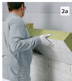
Lastra di isolamento lamellare in lana minerale Lastra isolante in lana minerale conforme allo standard EN 13162; elevata resistenza alla trazione grazie alle fibre verticali
