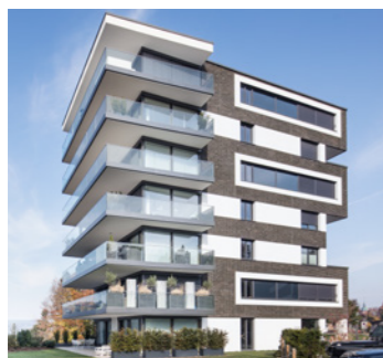
Wohnanlage Straßburgerstraße/Freudenstadt, DE
