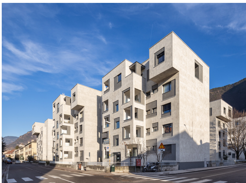
Gli edifici residenziali di via Aslago prima e dopo la ristrutturazione (sopra e sotto).
