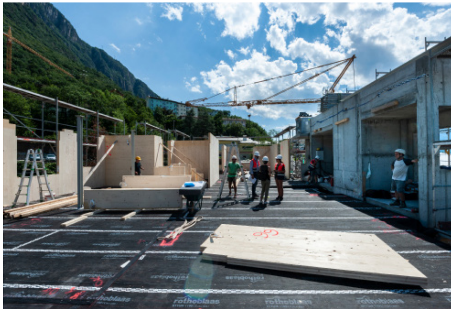
I pannelli prefabbricati in legno a strati incrociati consentono un rapido montaggio.
