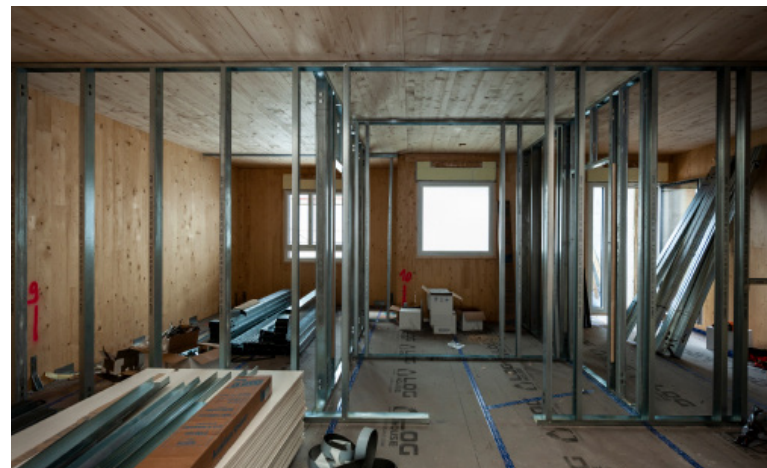
L'ultimo piano in pannelli di legno a strati incrociati, finiture interne con profili a C
