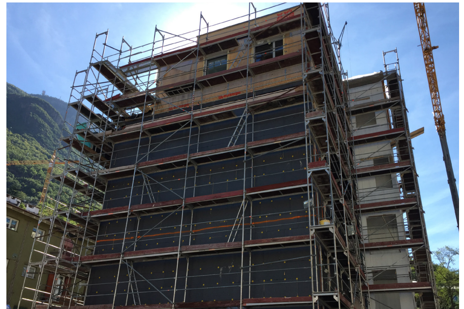
Installazione del nuovo involucro termico sulla facciata esistente
