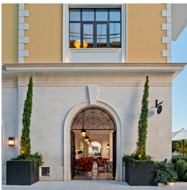
Dettaglio Hotel Regent, Teodo - Montenegro
