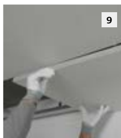
Figura 11: Montaggio dei pannelli nella zona del bordo e del giunto di testa
