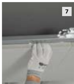
Figura 10: Incollaggio corretto dei pannelli fonoassorbenti
