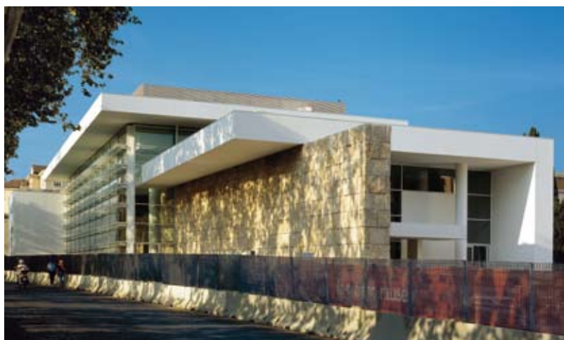
Sistema di facciata ventilata | StoVentec installato al Museo Ara Pacis Architetto: Richard Meier - Roma, I
