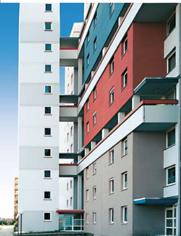
Complesso residenziale Stauffer, Waiblingen, D | Malte minerali
