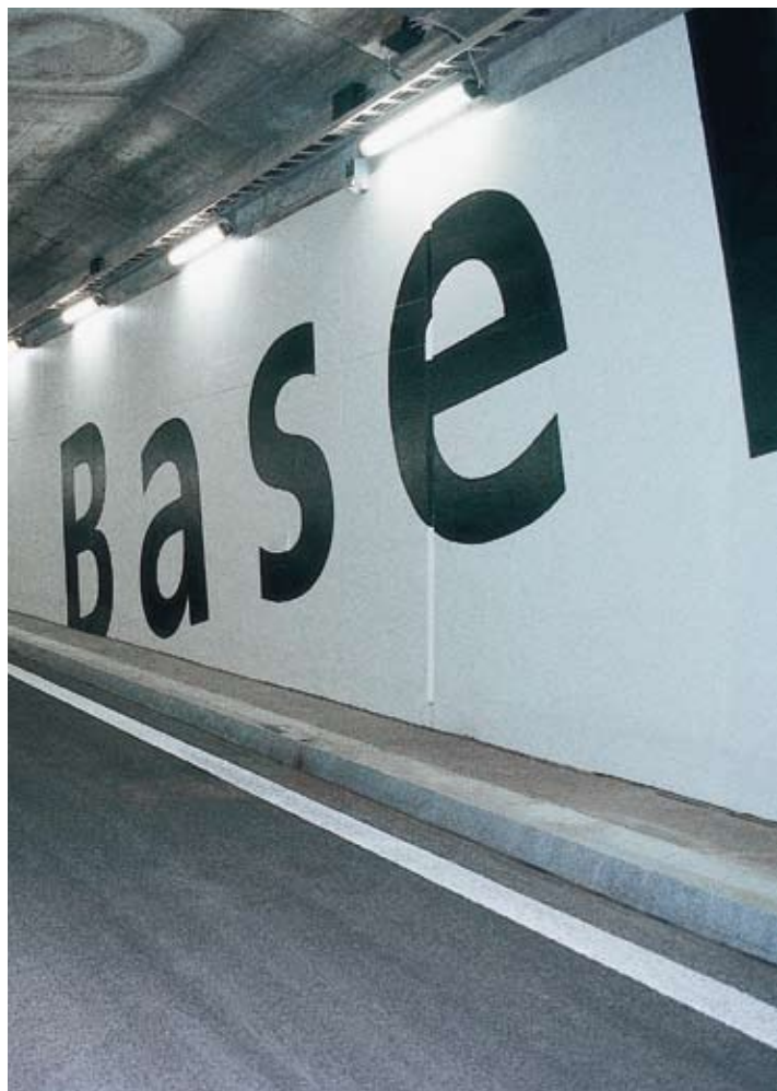
Galleria N2 tangenziale nord, Basilea | CH, Ripristino calcestruzzo: trattamento idrofobizzante / primer con StoCryl GW 100
